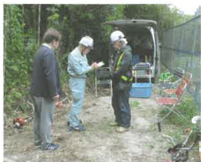
安全パトロールの様子
